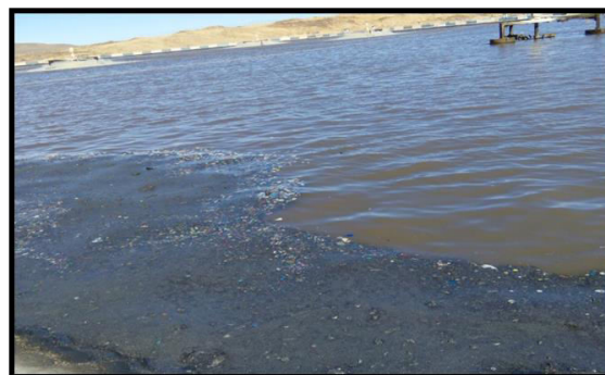
Fig.4 : Photos montrant les huiles flottant dans les bassins d'aération
